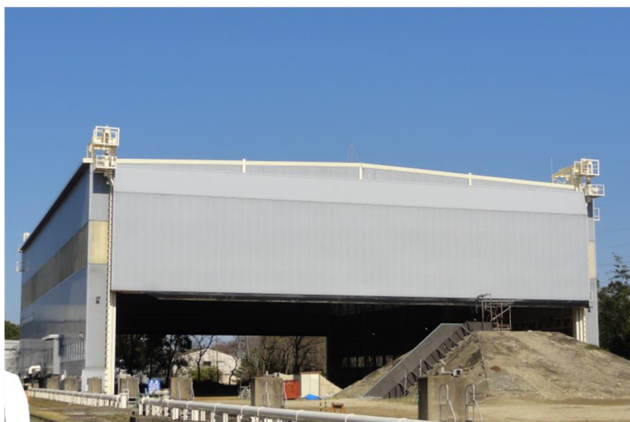
写真3：大型降雨実験施設全景。
