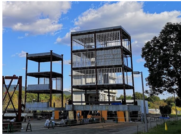
図2 試験体の施工状況（2020年10月26日）
