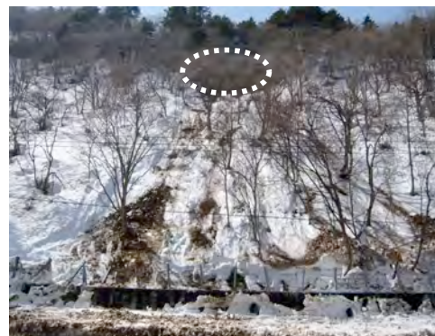
図1 雪崩斜面 上部の点線部分が発生区。雪崩は落石防止柵を乗り越えて道路に到達した。
