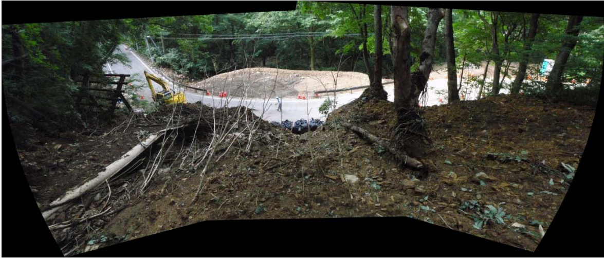
写真 4. 崩壊源から下方を見る.
