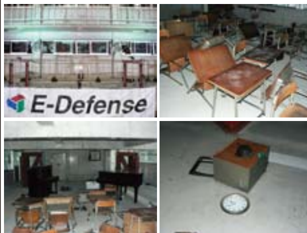
写真3 極短柱の破壊状況及び室内の様子（10月2日の実験後）
