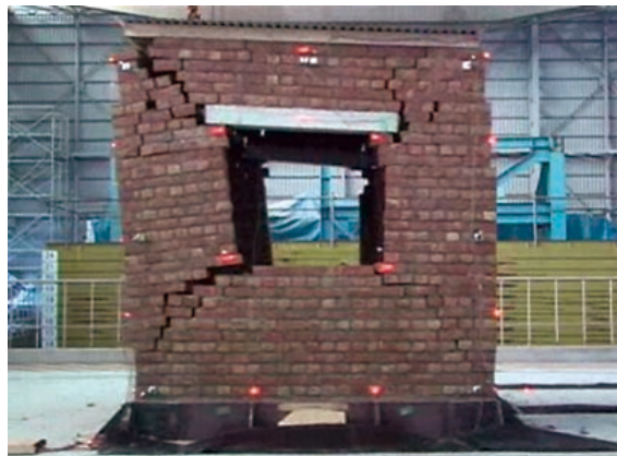
写真1 開口部四隅から広がる亀裂
