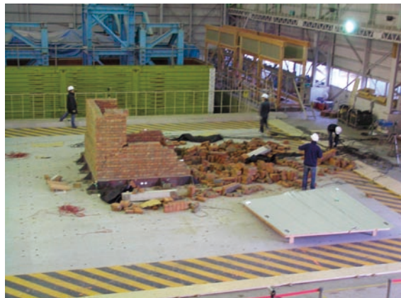
写真2 崩壊したモデルレンガ試験体
