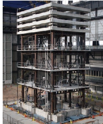
写真1 骨組の安全性に関する実験
