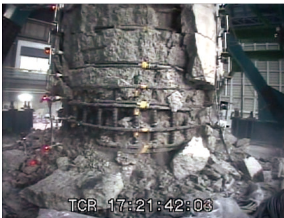
写真4 現行基準の橋脚（余裕度検証後）。現行基準では、以前の基準よりも多くの鉄筋が使用されているので耐力の向上がみられる。錘を1.2倍とし震動台の揺れを1.25倍として2回揺らせた結果、内側のコンクリートが鉄筋より外へ割れ出た。
