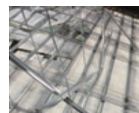
図4 JMA神戸波150%での加振実験により破壊させた耐震天井
