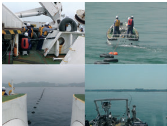
写真4 ケーブル陸揚げ風景。左上) ケーブルに浮環を取り付けながら繰り出す。右上) 作業ボートで陸まで牽引。左下) 千葉県南房総市での陸揚げ。右下) 茨城県鹿嶋市での陸揚げ。
