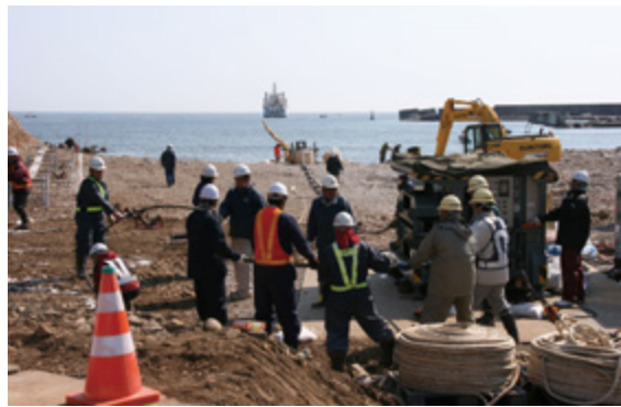
写真2 沖合いの敷設船から海底ケーブルを引き揚げている様子
