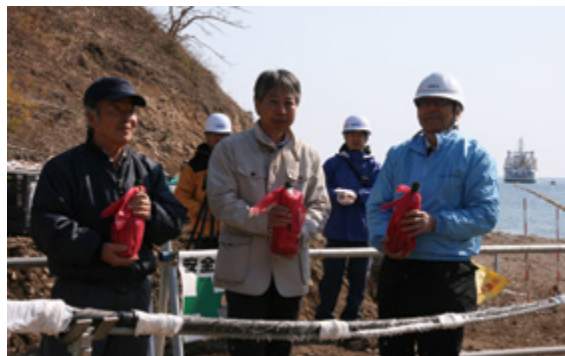
写真3 無事に陸揚げされた海底ケーブルを囲む関係者
