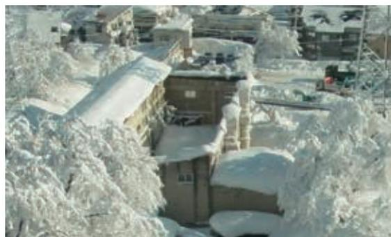
図1 湯沢発電所の建物の屋根崩落
