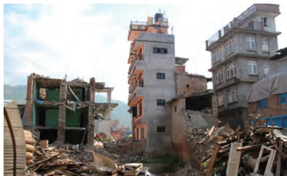
写真5 RC建物は健全で構造形態の違いが顕著（Sanhku）
