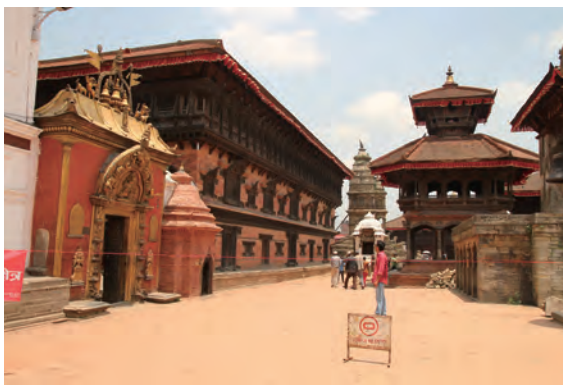
写真2 Bhaktapur王宮は耐震補強がなされ、1934年の地震のような被害は免れました。
