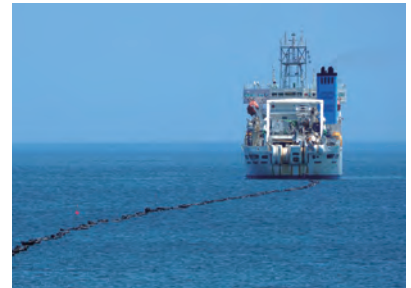
写真4 陸に向けてケーブルを繰り出す敷設船「すばる」
