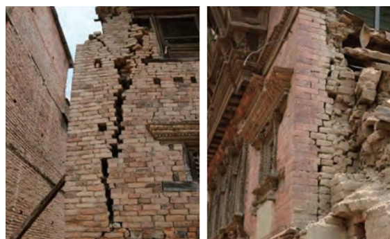
写真6 RC枠組を持たない構造（Sanhku）
