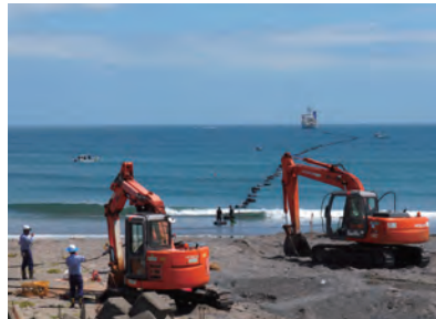
写真3 ケーブル陸揚げ作業の様子
