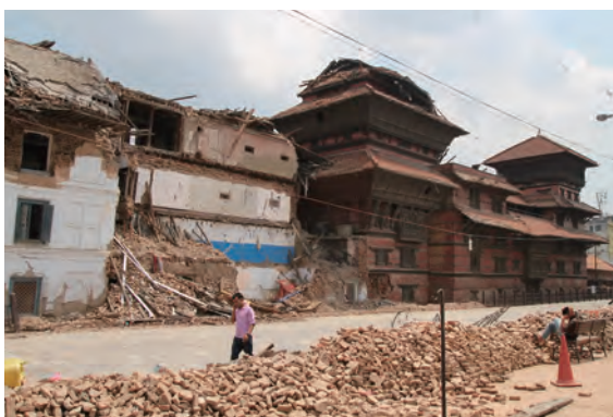
写真4 Kathmanduのダルバール広場は、対策がされていないため、多くの被害を受けました。
