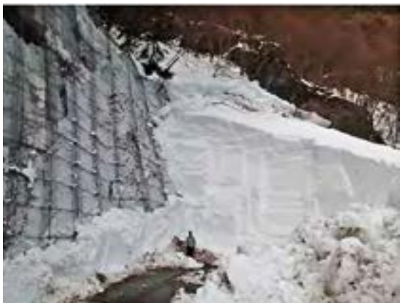
写真1 雪崩に埋まった道路(山梨県甲府市)
