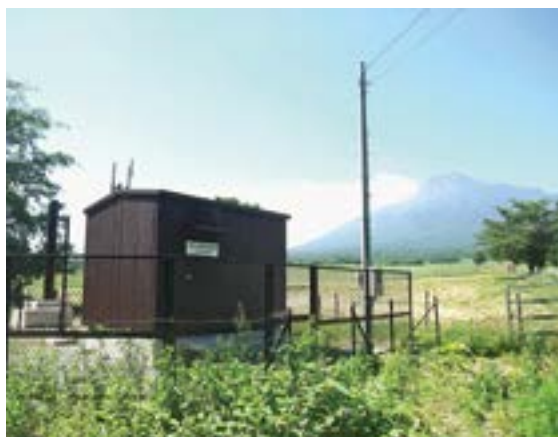
写真1 岩手山の火山観測施設
