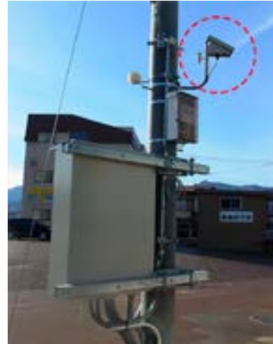
図1 消雪パイプ制御用の降雪センサーの例(写真右上の装置)
