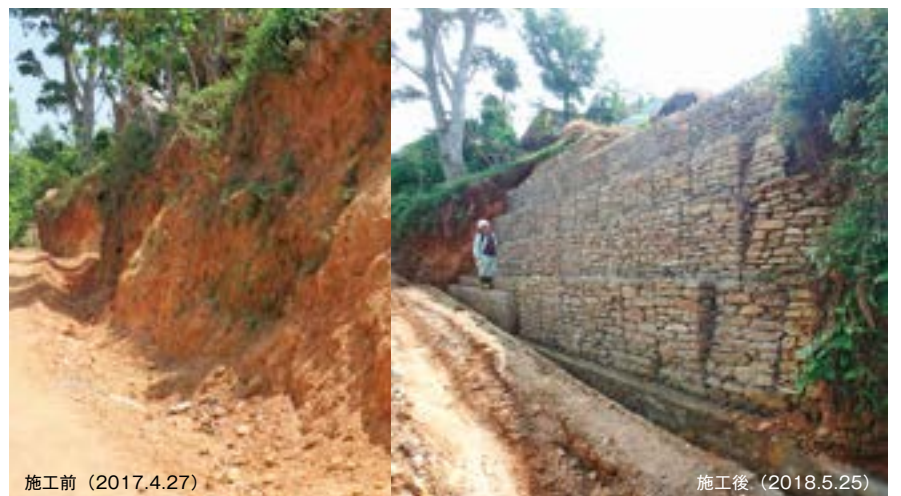
写真2 蛇籠擁壁試験施工（JICA事業）
