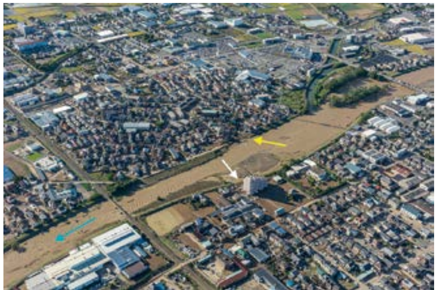
写真1 中流域の被害の例。南流する秋山川（水色矢印）が住宅密集地沿いで破堤（黄色矢印）し、写真の左上端まで浸水。また、その対岸では越流（白矢印）が生じ、広い範囲で住宅地が浸水した。
