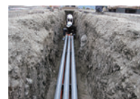
局舎へ繋ぐ管路整備
