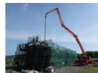
コンクリート打設
