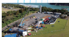
工事中の敷地内全景
