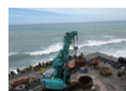
海岸部でも工事を実施
