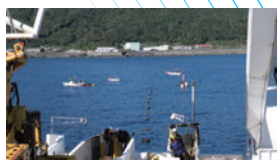
敷設船から見た作業の様子
