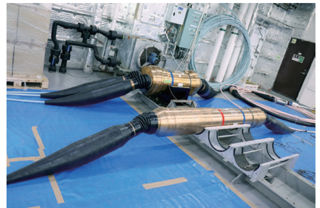
図 敷設船上の観測装置（手前）と分岐装置（奥）
