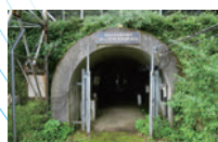
東京大学地震研究所 鋸山地殻変動観測坑
