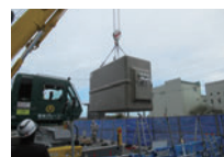
ビーチマンホールの設置
