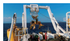
すき式埋設機の投入
