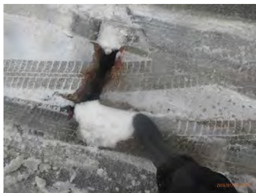
消雪パイプが機能していない (接合部の破断) : 氷見市北大町
