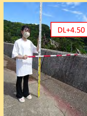
昭和南海地震の波高に合わせた堤防高さ
