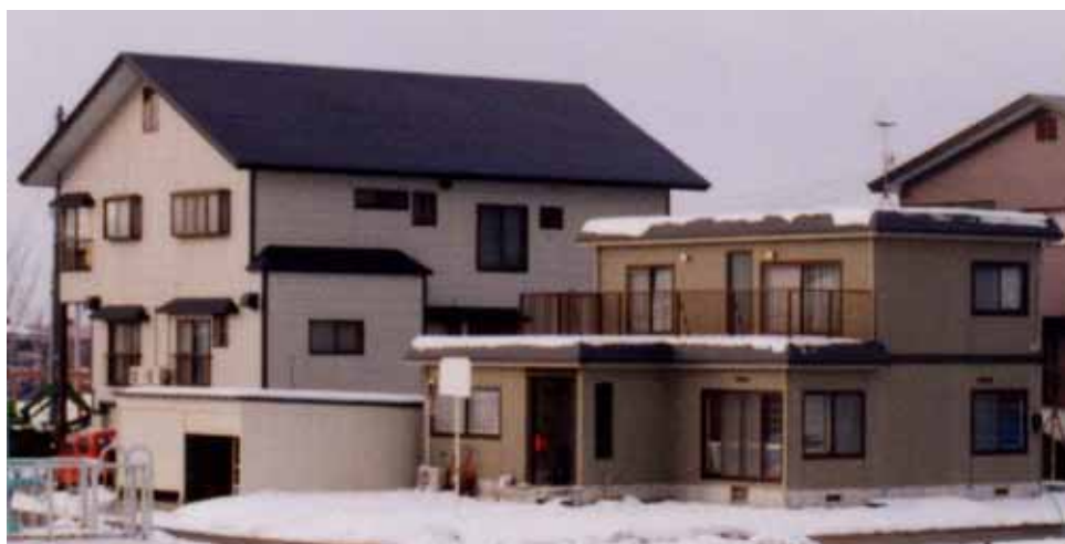
図 1 自然滑落方式(左)と耐雪方式(右)の住宅
