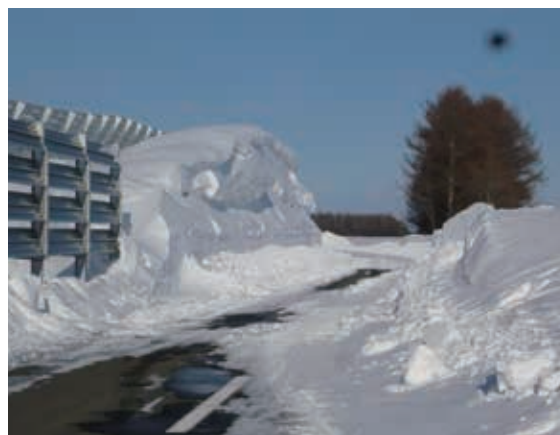
図2 中標津町西竹付近の町道に形成された吹きだまり。2月4日撮影。卓越風の向きは左から右。
