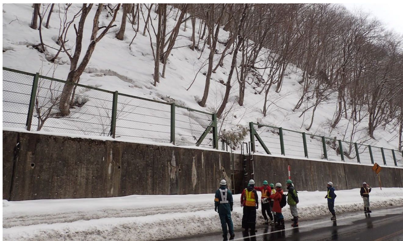
図2 斜面積雪の除去作業による雪崩対策
