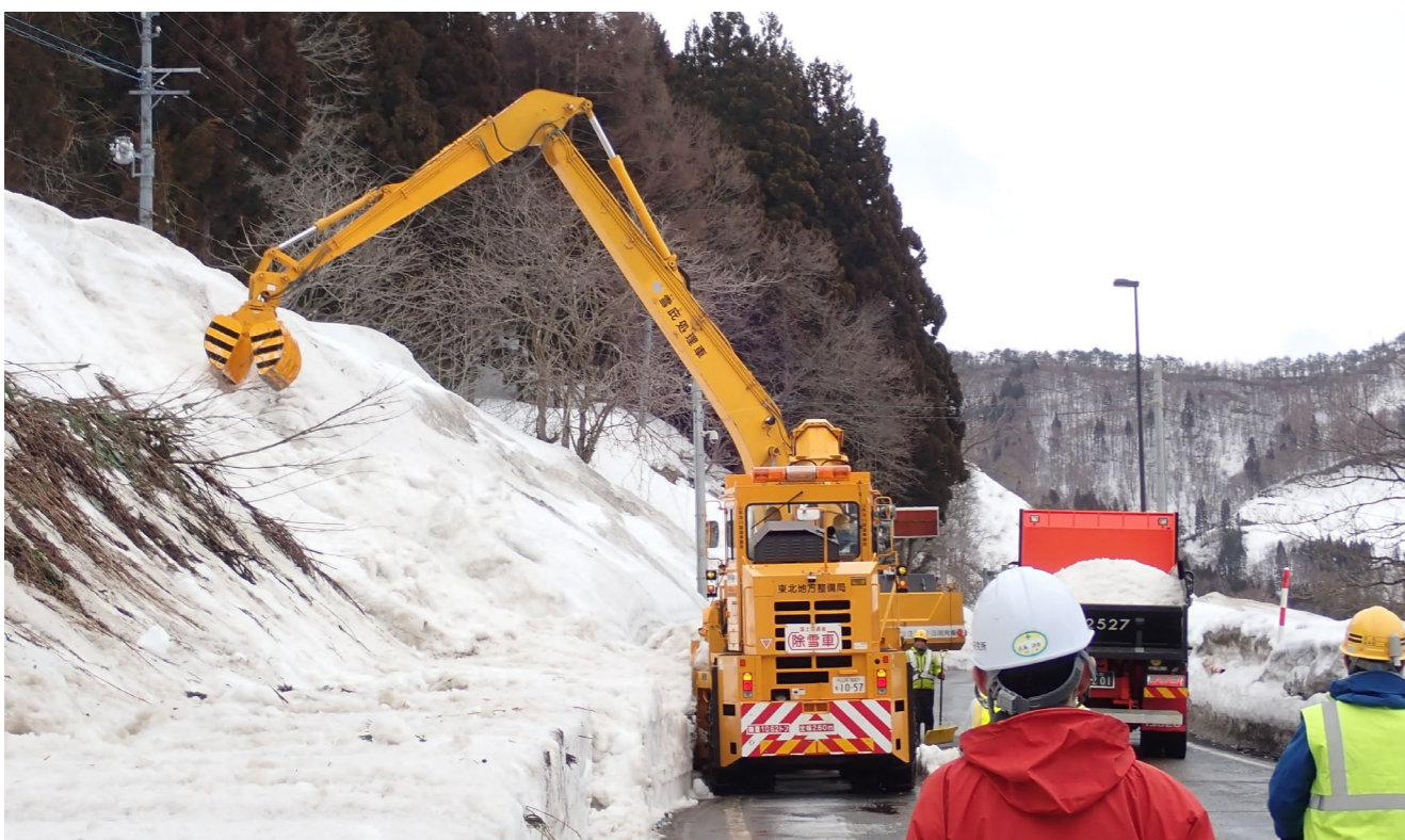
図3 斜面積雪の除去作業による雪崩対策
