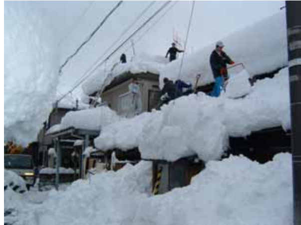
市内の屋根雪下ろし作業
