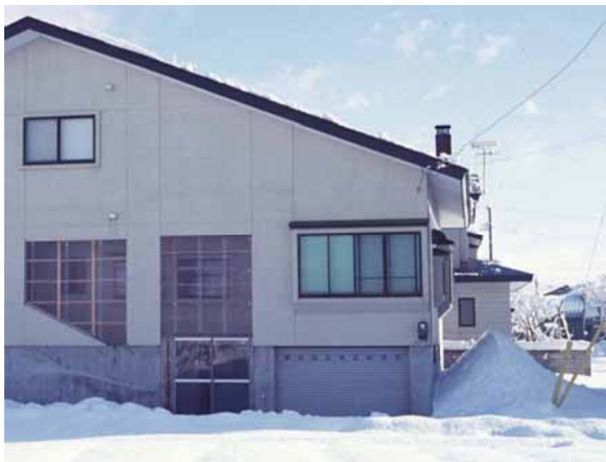
図 2 自然滑落方式の軒下落雪．初冬時でまださほど堆積していない．
