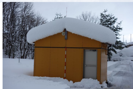
雪氷防災研究センターに設置された準実大屋根雪実験棟 (新潟工科大学との共同研究)
