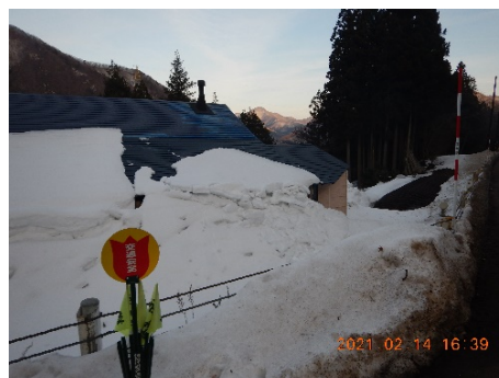
図4 屋根雪の地震による崩落（猪苗代町長坂）
