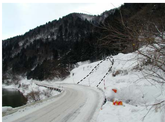
図 1 雪崩跡と周囲の写真。雪崩跡(破線)のある法面の上を JR 陸羽西線が走る。写真中央は国道 47 号、左端の水面は最上川である。
