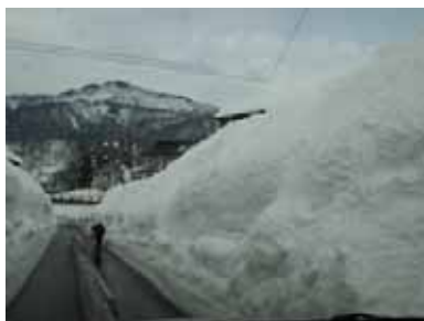
写真 2 雪山によって狭くなった道路
