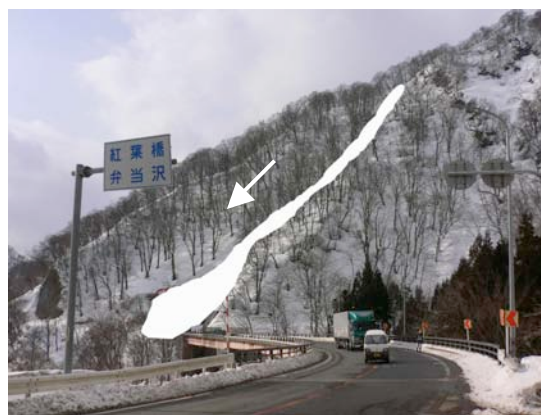
図 2 雪崩走路（実際は樹木に隠れているので白抜きにより強調してある）。雪崩は最上部の尾根直下で発生し、トンネル出口付近に堆積した。
