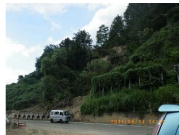
図4 地震による表層崩壊・雪崩発生、豪雨により表層崩壊、予防柵埋積(十日町市池尻)
