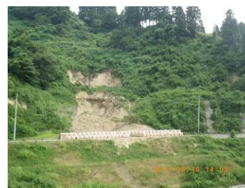
図6 中越地震で地すべりその後雪崩発生、豪雨により表層崩壊再発(長岡市桂谷)
