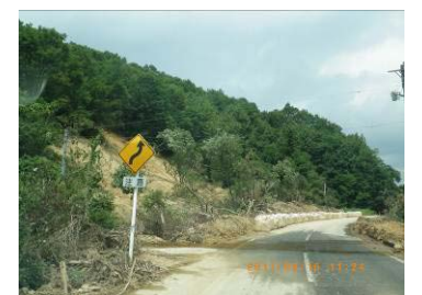
図7 豪雨により表層崩壊、道路被害(三条市境)
