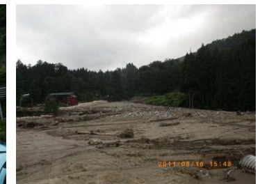
図5 大規模土石流(南魚沼市土沢)
