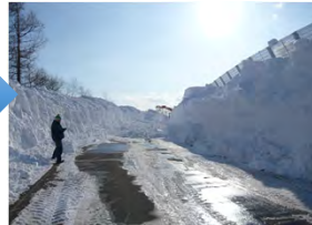
吹きだまりで埋まった道路(除雪後)
