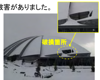
仙台市屋内グラウンド屋根破損 周囲で積雪量調査実施
