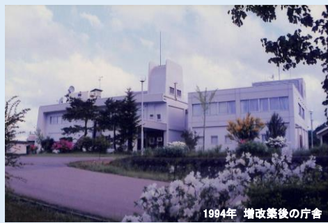
1994年 増改築後の庁舎
