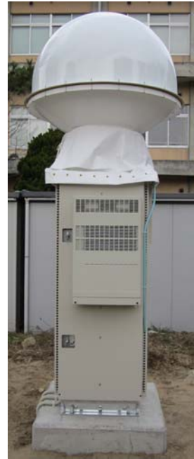
図1. 新潟大に導入された気象ドップラーレーダー(対流圏DBSシステム)
