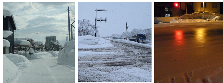
冬期の路面状態 (左:圧雪, 中:シャーベット, 右:凍結路面)
