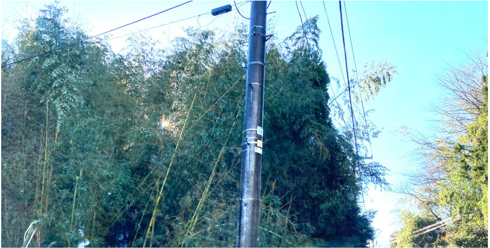
写真7 電線の近くまで生えている竹林
