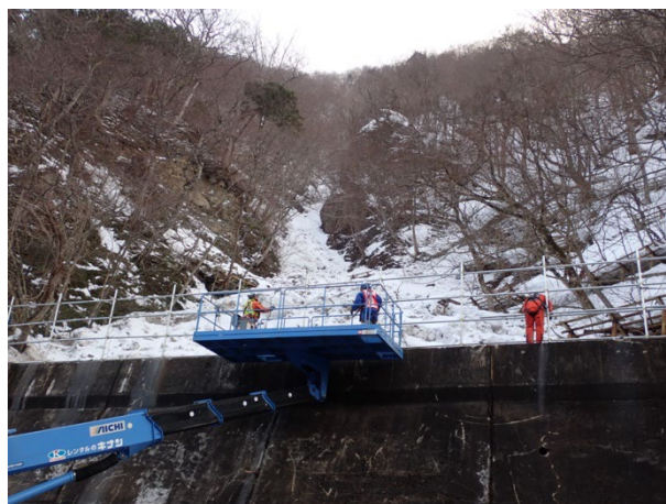
図 2 応急対策工設置状況 (2022/3/21)
