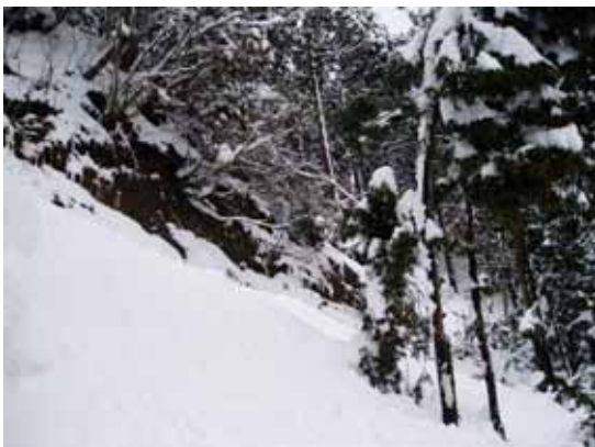
写真 2 土砂崩れの写真 1
