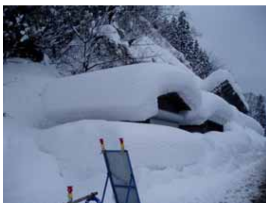
写真4 土砂崩れ発生地点付近における積雪の様子
