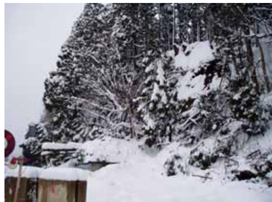
写真 3 土砂崩れの写真 2
