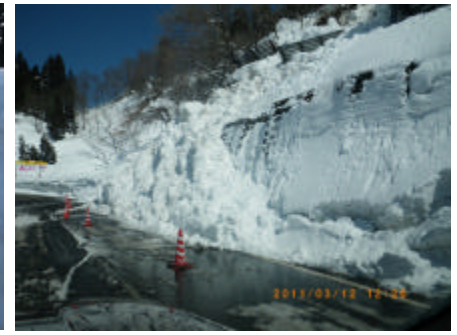
写真 15 道路法面からの積雪の崩落 (新潟県十日町市)
