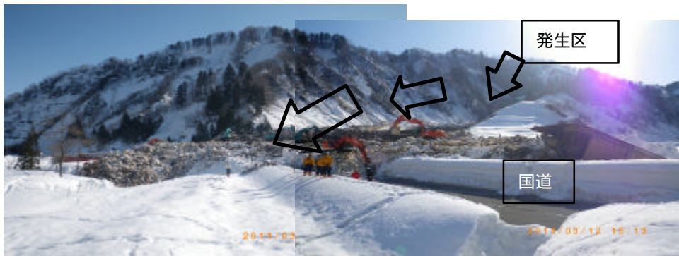
写真 16 地震による斜面崩壊と雪崩、流動性が高く道路まで到達 (新潟県十日町市)
