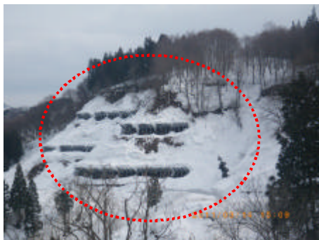
写真 7 地震によって発生した雪崩、雪崩予防柵上部から発生（新潟県十日町市）
