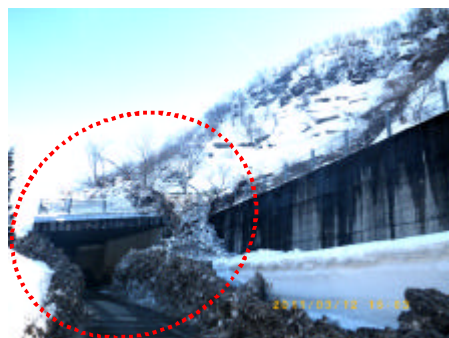
写真 5 地震によって発生した全層雪崩（新潟県津南町） スノーシェッド設置箇所手前の道路を埋雪
