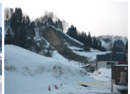
写真 17 雪崩予防柵を設置した法枠工斜面の崩壊 (新潟県津南町)
