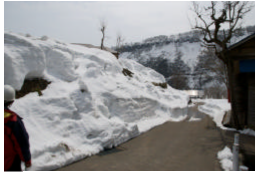
写真 22 一週間後の状況 道路脇の法面 からの崩落雪とクラック(長野県栄村)
