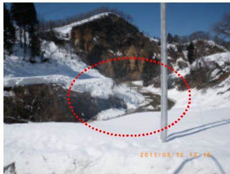
写真 26 地震による雪崩によってダムアップした河川(新潟県十日町市: 渋海川)
