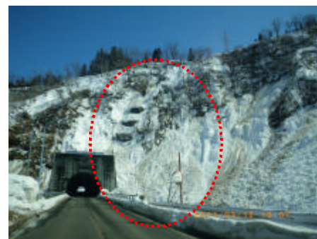
写真 6 表層雪崩・全層雪崩・クラック同時発生（新潟県十日町市）
