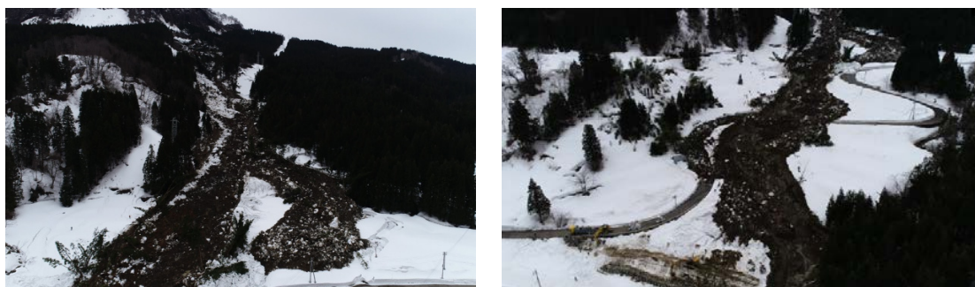
図 2. 地スベリ発生領域上流部 (左) と下流部 (右) の状況
