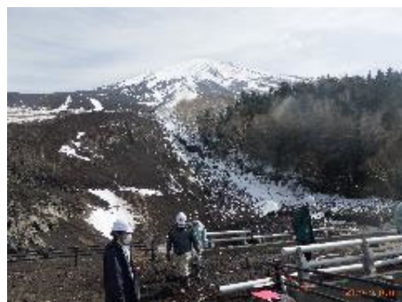
図4 石楠花橋付近のスラッシュ雪崩発生状況
