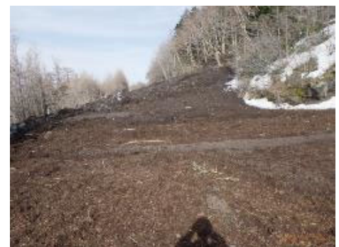
図3 石楠花橋～青草洞門の道路堆積状況
