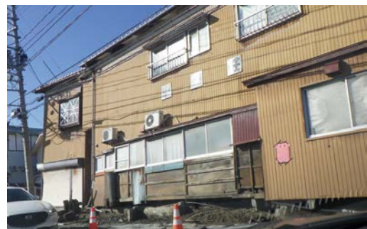
写真 3 液状化による家屋被害 新潟市西区
