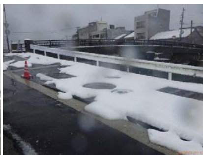
写真 5 道路上の段差 氷見市
