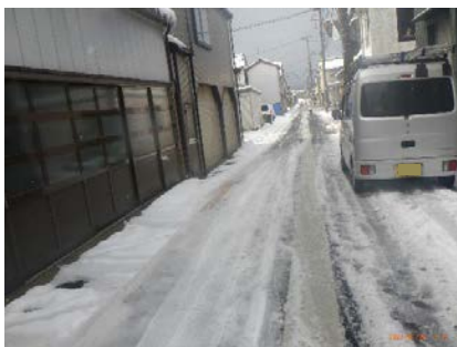
写真 2 消パイ設置路線 氷見市
