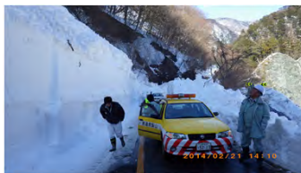
山梨県丹波山村 411号線沿 雪崩で埋もれた道路の除雪後の安全確認
