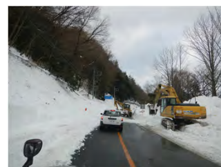
県道の雪崩対策緊急点検を実施し、 応急対策を山梨県にアドバイス
