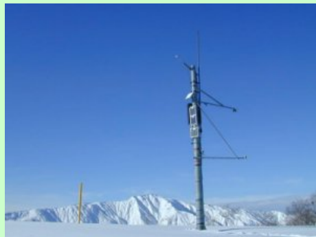
山地観測点とデータ収集システム
