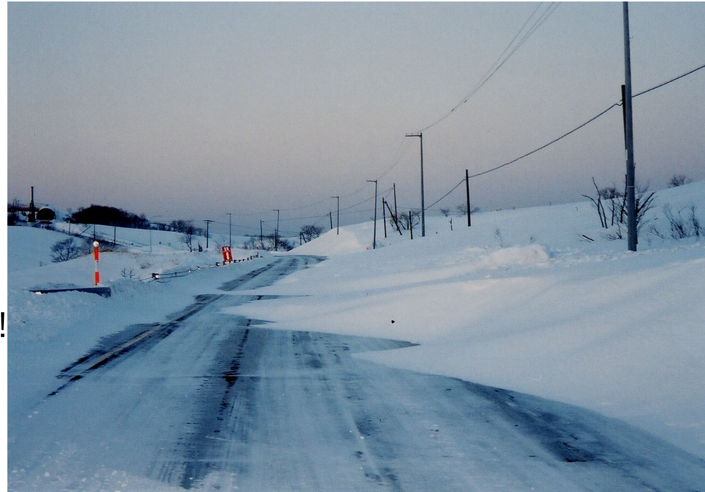
吹きだまりによって、道幅が制限された道路。 右側の電柱が本来の道幅を表す。
