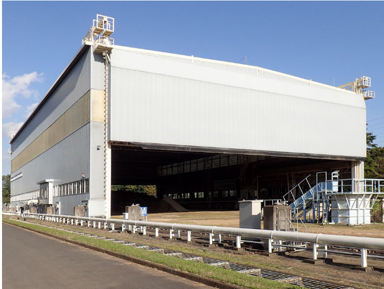
(大型移動降雨装置全景)
