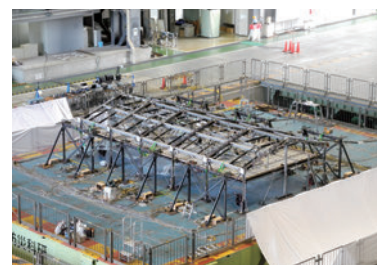
図2 縮小体育館実験
