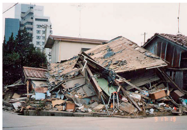
図1 兵庫県南部地震で倒壊した住宅
