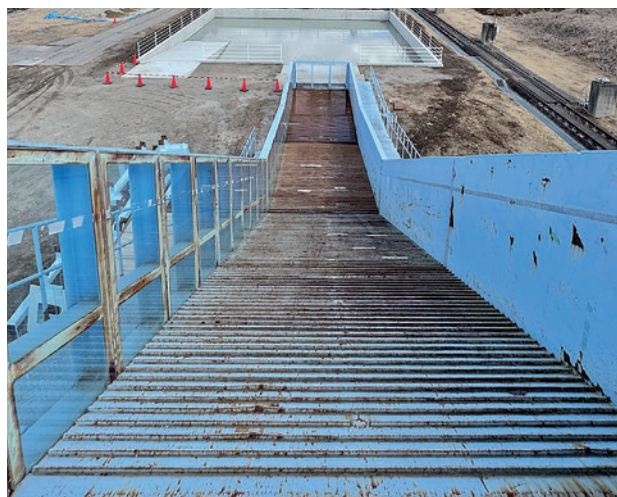
図3 大型土砂流下装置 上：流下装置全景、上部に水槽を設置し、下部に貯水槽が設置されている 下：流下装置から見下ろした下流の貯水槽
