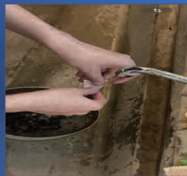
図8 内膜の除去作業
